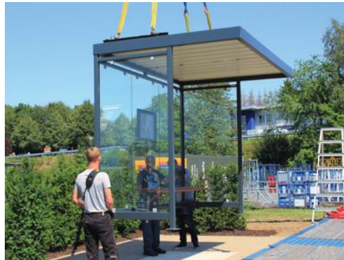
Montage in einem Stück: Aufstellung einer komplett verschweißten und montierten Wartehalle durch unser Logistik- und Montageteam.
