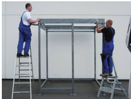
Einfache Selbstmontage: Bausatz aus Einzelteilen mit Schraubverbindungen (Montage vor Ort).
